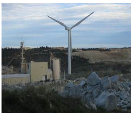
Eolienne de Centernach
