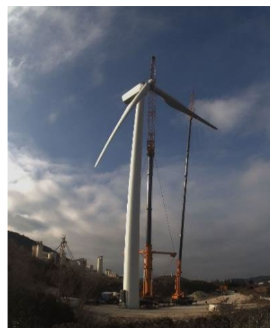
Démantèlement de l'éolienne
